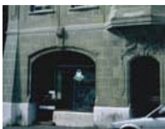
Type 2 Maçonnerie apparente
