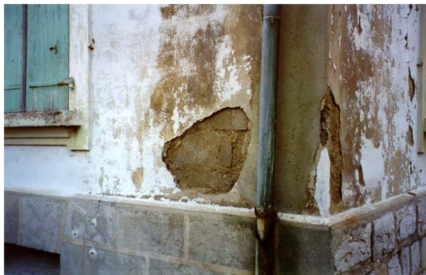
Figure 5 – Façade en crépi en code d
