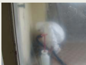
Assainissement avec protections requises
