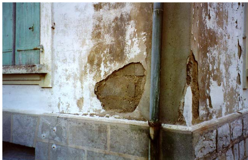
Figure 5 – Façade en crépi en code d
