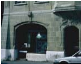
Type 2 Maçonnerie apparente
