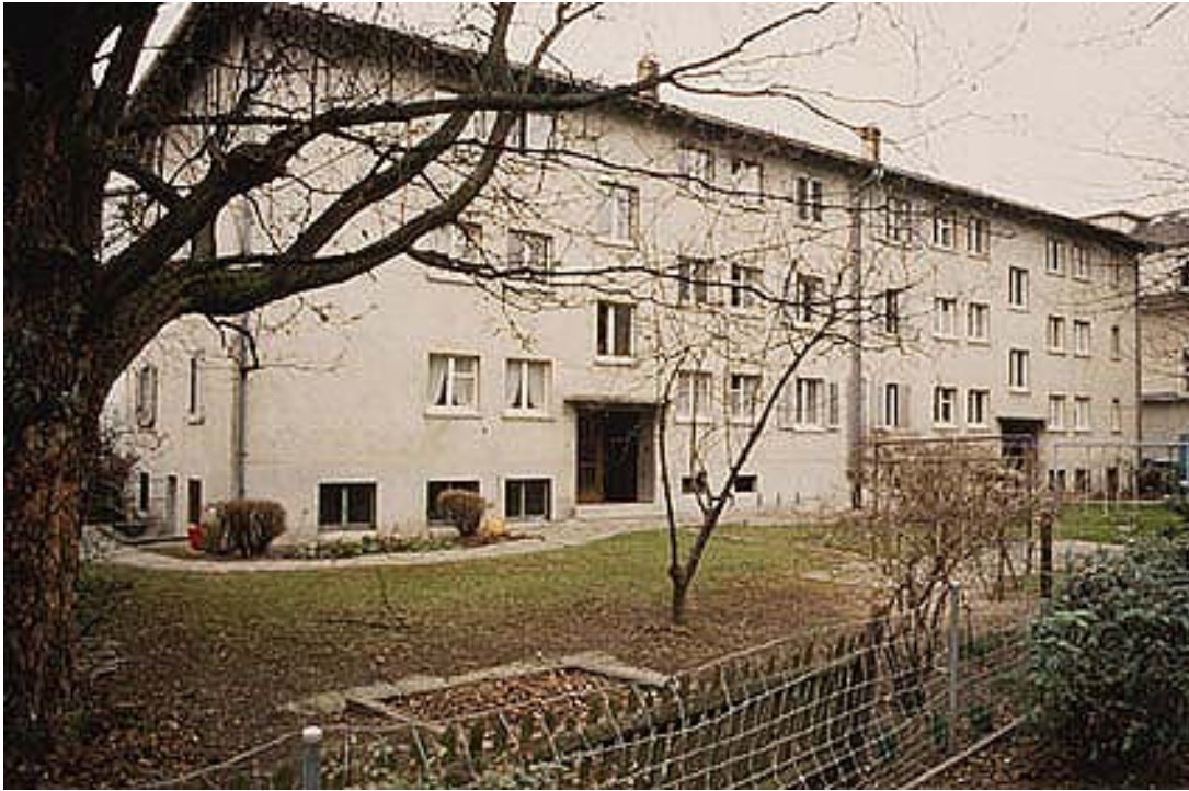
Figure 12 – Immeuble Friesstrasse 28/30 à Zurich.
