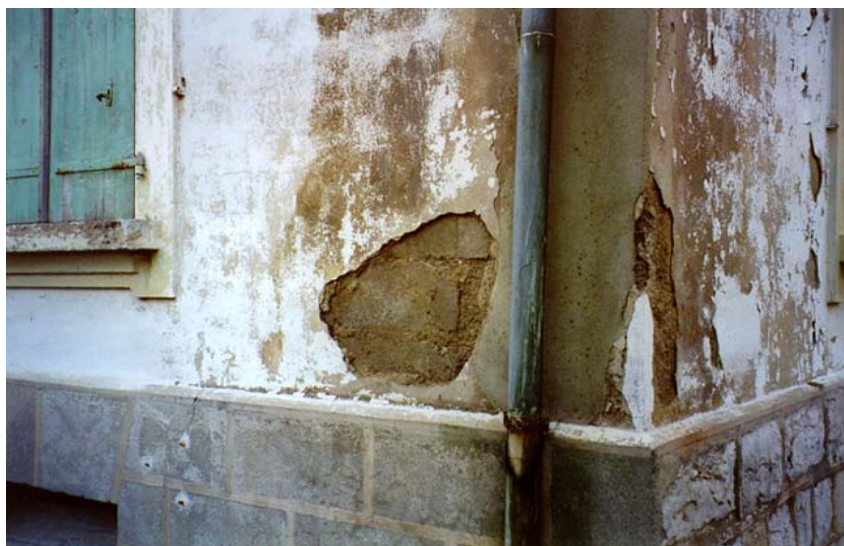
Figure 5 – Façade en crépi en code d
