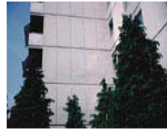
Type 3 Eléments préfabriqués en béton
